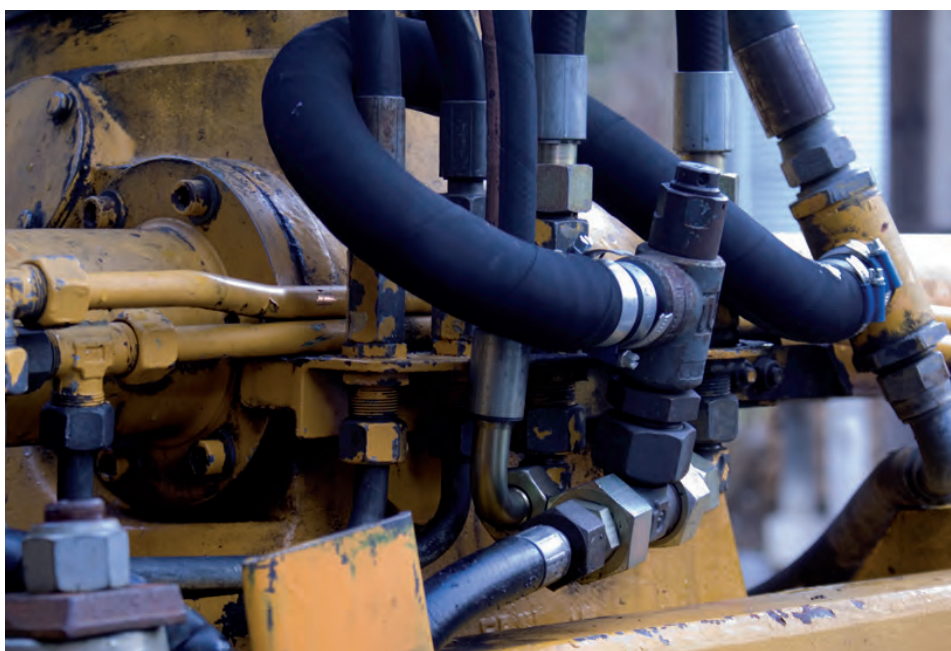
Afb. 7. Onderling slecht gerouteerde slangen
